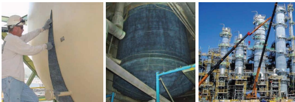
شکل ۱۳- عایق کاری واحد پلی کربنات با عایق بلنکت هواژل (کره جنوبی)
